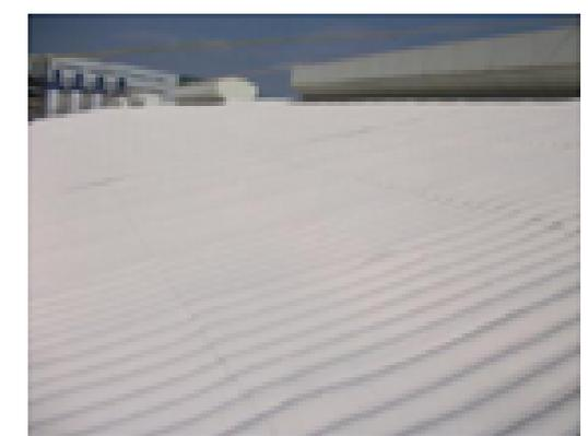
スレート屋根の素地に対し、その表面に瞬間硬化型ポリウレタンフォーム(接着断熱層)を吹付、その表面に、高強度・伸延性等を有する瞬間硬化型ポリウレタン樹脂(補強防水層)を吹付、その表面に、耐紫外線・耐飛火性等を有する表面層(トップコート層)を塗布。3層構造からなる樹脂層を形成する。
