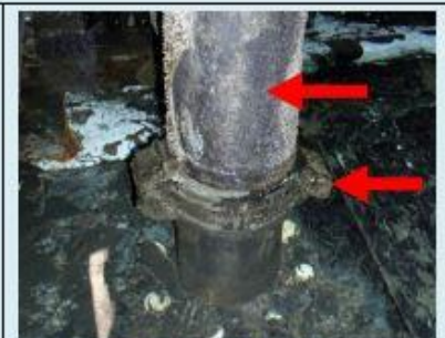
ACR設置後4カ月経過した状態
