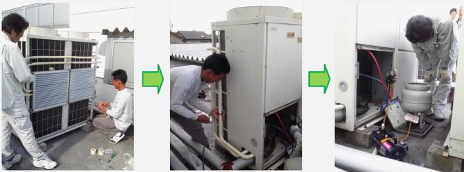
スパコンパネル取付 (凝縮機面積拡大装置) → 既存配管へ接続 → 既存冷媒ガス (R22) 抜取 新冷媒ガス (HB156) 充填
