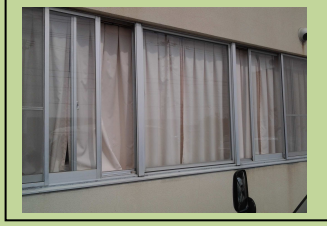
《施工前はカーテンで締切る 昼間でも照明を点灯していた》
