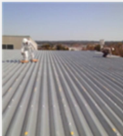
①清掃・錆取り
