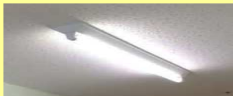
※【写真】施設内 一部照明
