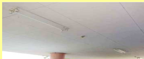
※【写真】屋外駐車場 一部照明
