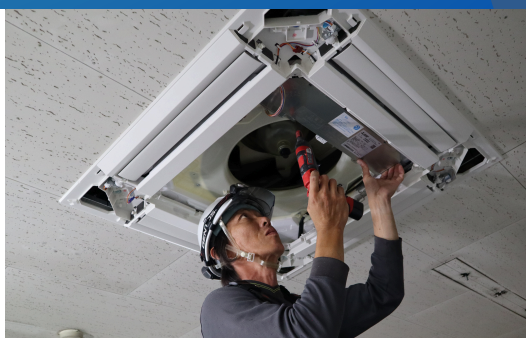
空調機新設・更新
